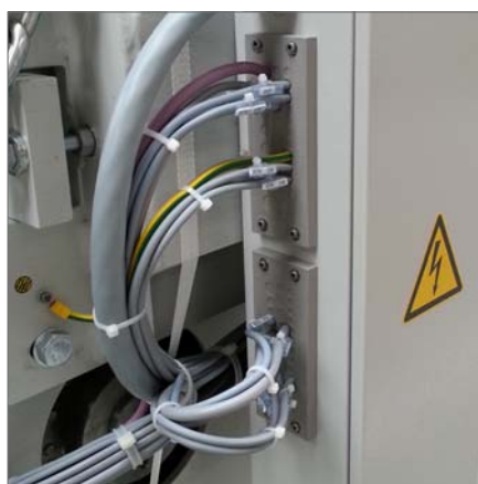
KEL-DPZ 24|x - Página 62 - 63 Entrada de varios cables a través de la pared del armario con IP65. Para futuras ampliaciones se reservan espacios vacíos.
